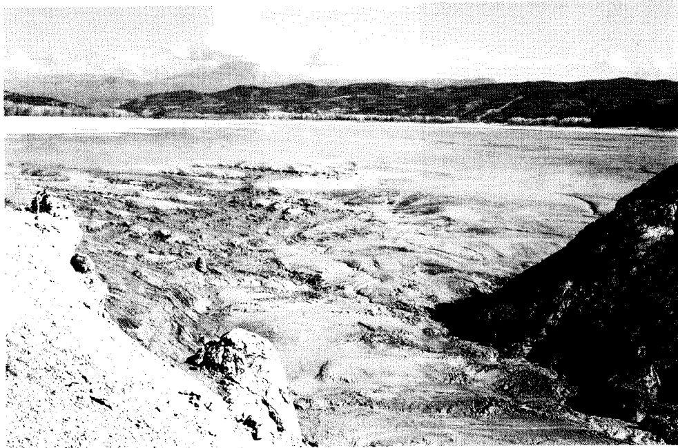
Figura 25. Movilización del sedimento del embalse en la zona más próxima a la presa al ser arrastrado por el agua durante el primer vaciado (Octubre de 1995). Starting of the sediment drags during the first flushing (October 1995).
